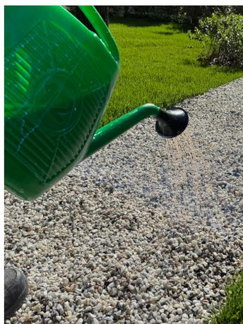
Applicare il primo strato sulla superficie pulita e asciutta, spruzzando lentamente in modo uniforme.
